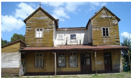
Fachada principal (Norte), situación actual.
