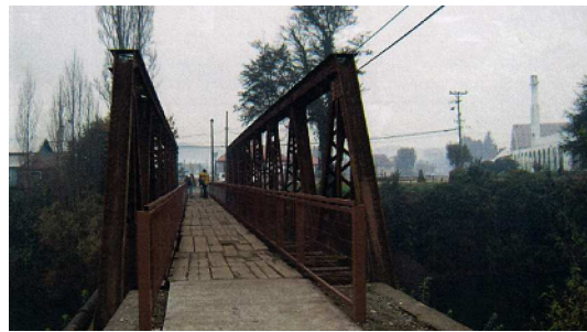
Vista del Puente de Collilelfu
