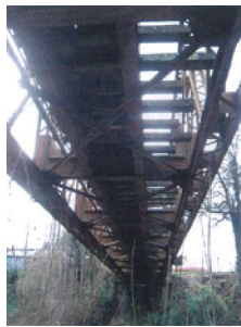
Vista del Puente de Collilelfu
