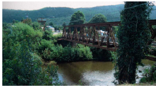
Vista del Puente de Collilelfu
